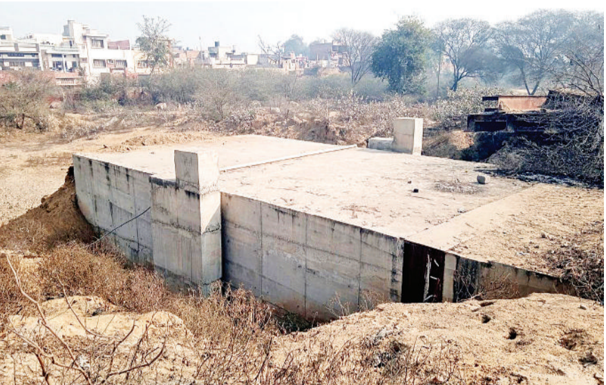
जाखल। रेलवे अंडरब्रिज जो निर्माण कार्य पूरा होने की बात जो रहा है।
